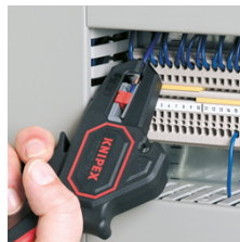
Abisolieren unter beengten Platzverhältnissen
